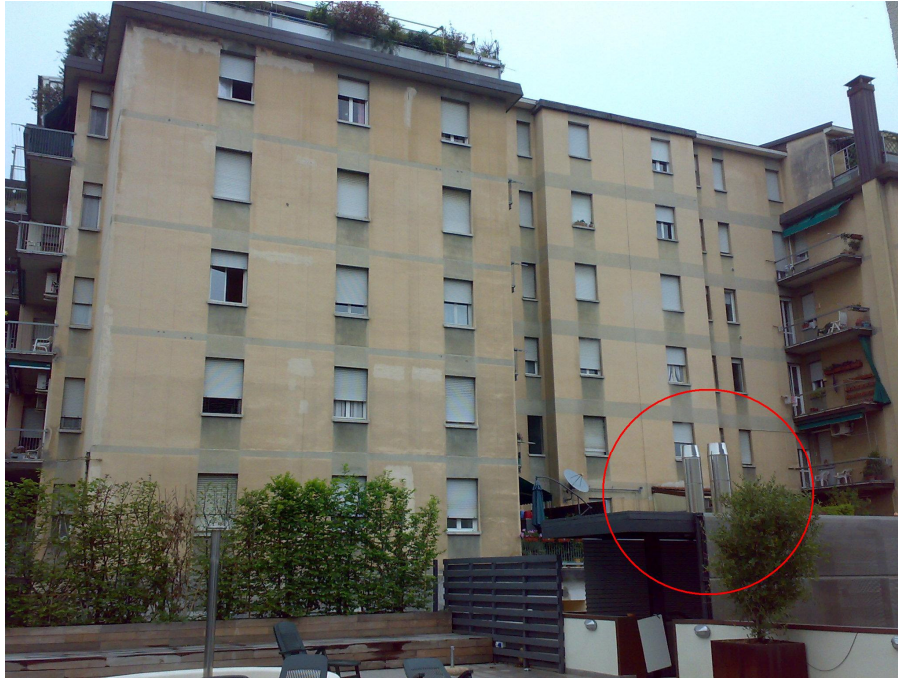
Fig. 6 - Camini di un impianto termico centralizzato
