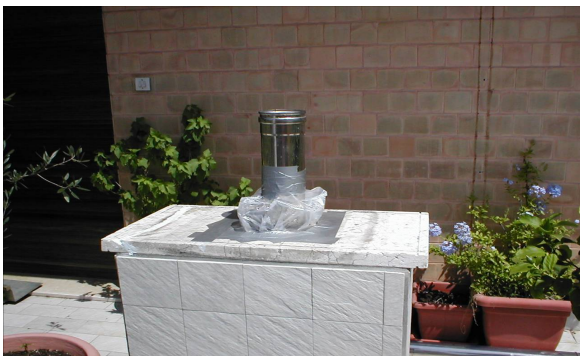
Fig. 5 - Scarico di un boiler sul terrazzo di un'unità abitativa
