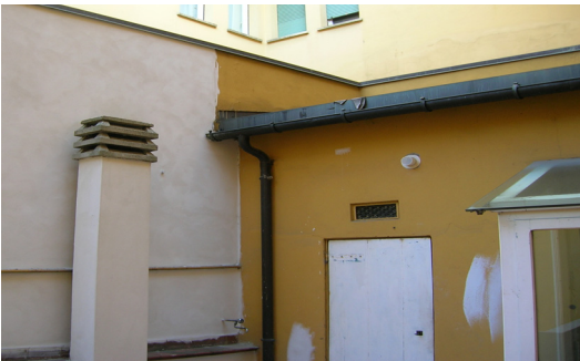
Fig. 4 - Scarico del generatore sul terrazzo di un'unità abitativa
